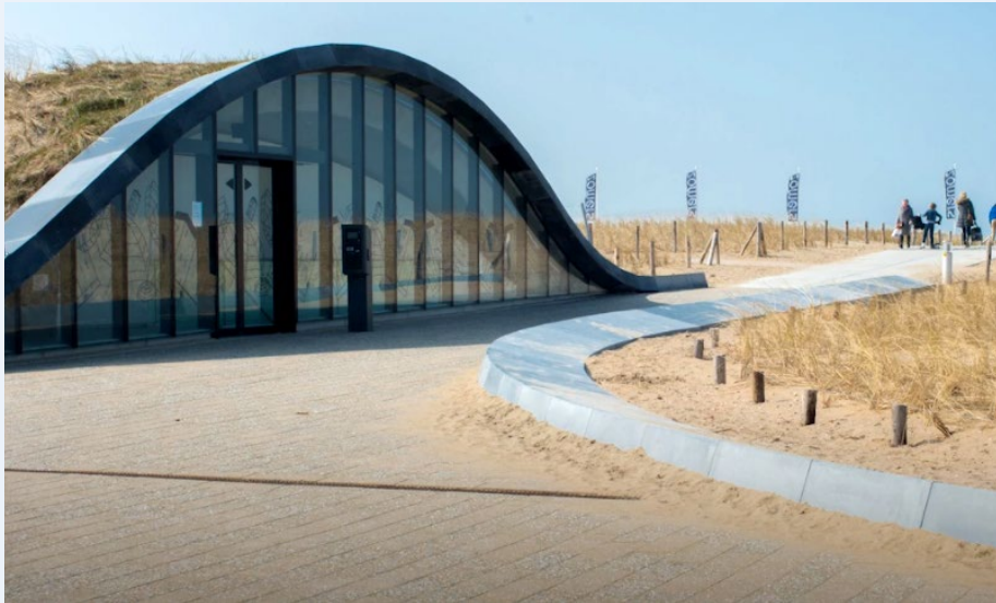
Katwijk aan Zee dike redesign by Arcadis Netherlands, Royal HaskoningDHV, OKRA Landschaparchitecten, and WB de Ruimte (Photo: Arcadis)
